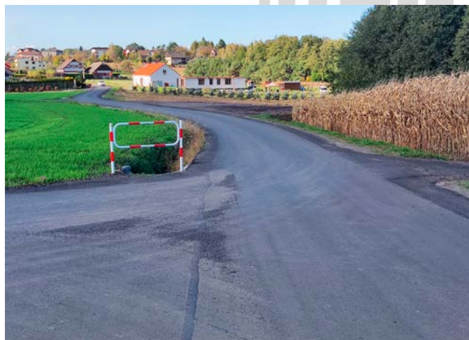
Ul. Graniczna po odbudowie
